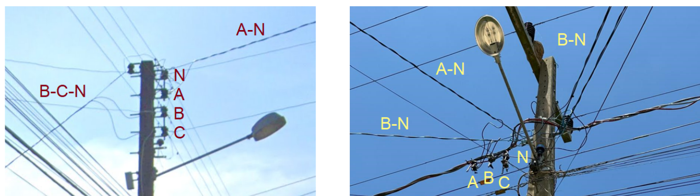
Figura 2. Exemplo de inspeção visual para identificação de relação de conexão TD-UC.
