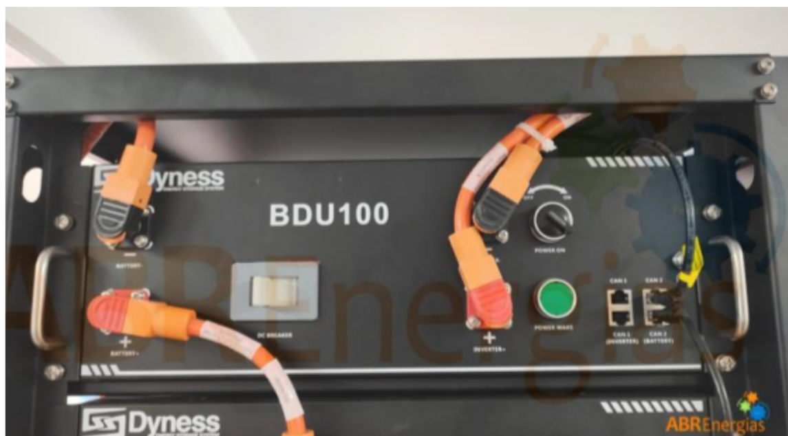
Figura 7 - Módulo De Controle E Proteção Do Cluster De Baterias
