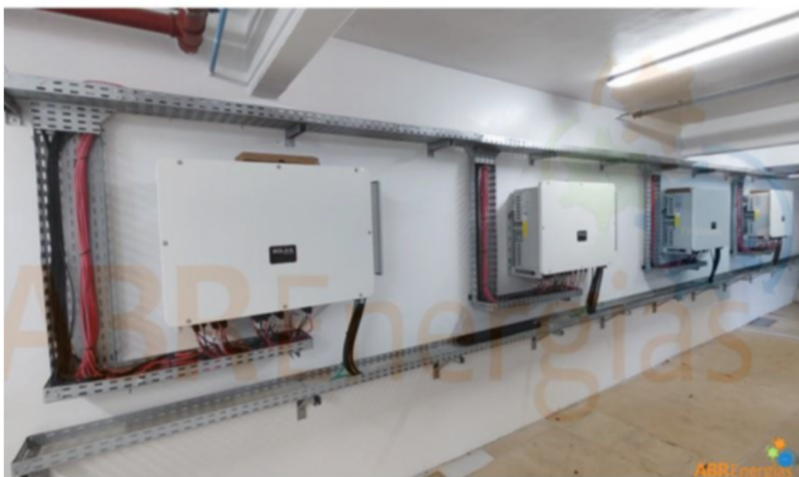
Figura 5 - Inversores da Usina Fotovoltaica
