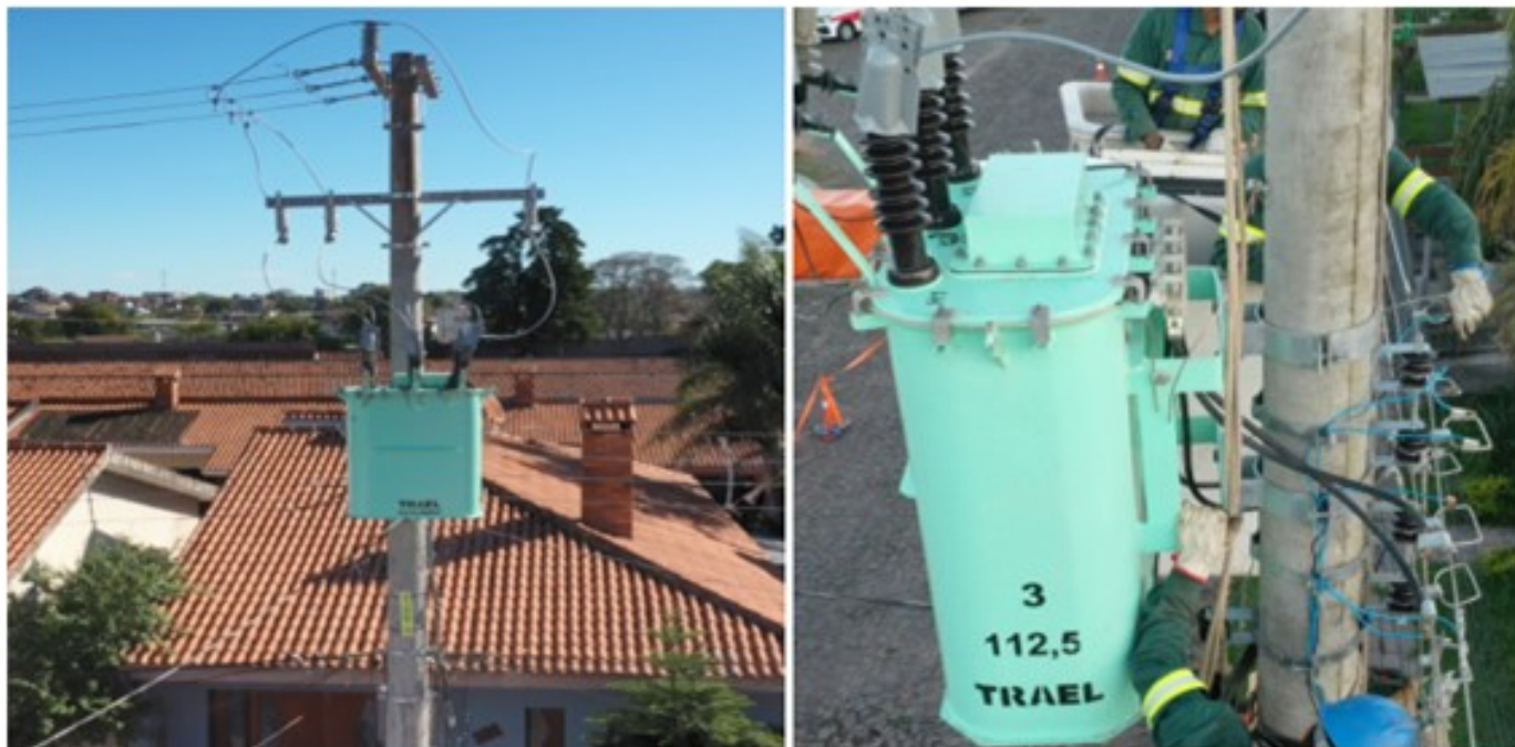
Figura 5. Transformador OLTC - Piloto instalado em Santana do Livramento/RS.
